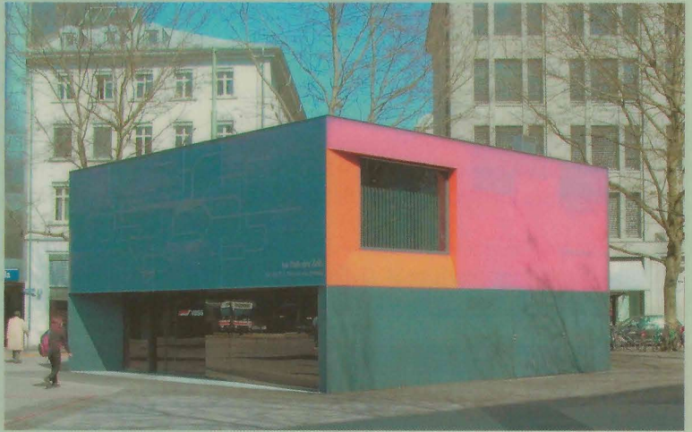
Der Pavillon der St. Galler Verkehrsbetriebe am St. Galler Bahnhofplatz mit GFK-Fassadenplatten von «Scobalit». Fotos: Scobalit AG/z.V.g.
