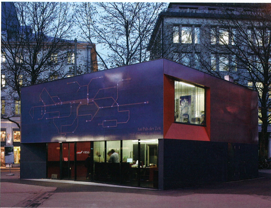
Bild 1 Geringe Kosten, schnelle Bauzeit (drei Wochen) und funktionale Überlegungen prägten die einfache kubische Erscheinung des temporär angelegten Verkaufs-Pavillons der Verkehrsbetriebe auf dem Bahnhofplatz von St. Gallen (CH). Auch die vielfarbige Fassade mit eingefrästem Liniennetzplan zeichnet ihn als „besonderes Bauwerk“ aus.
