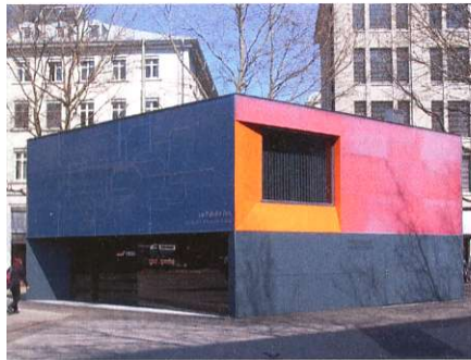
Preis vom Schweizer Bundesamt für Umwelt, Wald und Landschaft: Pavillon der Verkehrsbetriebe St. Gallen am Hauptbahnhof.
