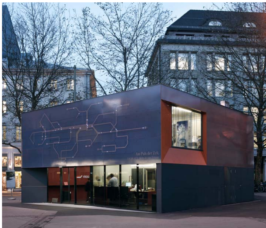
Bild 1 Geringe Kosten, schnelle Bauzeit (drei Wochen) und funktionale Überlegungen prägten die einfache kubische Erscheinung des temporär angelegten Verkaufs-Pavillons der Verkehrsbetriebe auf dem Bahnhofplatz von St. Gallen (CH). Auch die vielfarbige Fassade mit eingefrästem Liniennetzplan zeichnet ihn als „besonderes Bauwerk“ aus.
