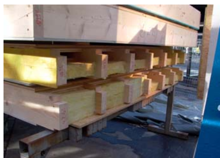
Bild 6 Die vorgefertigten Rippelemente bilden die Dach- und Deckenkonstruktion. Die an den Stirnseiten geschlossenen Deckenelemente ...
