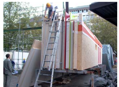
Bild 5 Die vorgefertigten Holzrahmenbau-Außenwände des OGs erhielten einen wetterfesten Farbanstrich.
