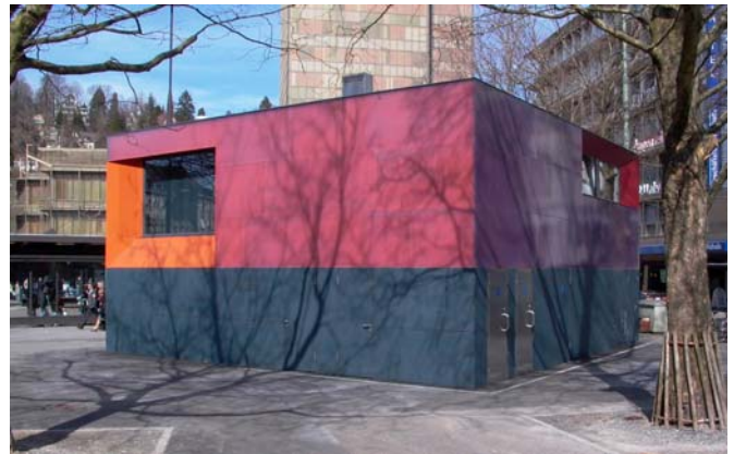
Bild 3 Die farbigen OSB-Platten, die das OG umhüllen, werden durch die vorgehängten Scobalit-Glasfaserplatten etwas gedämpft.
